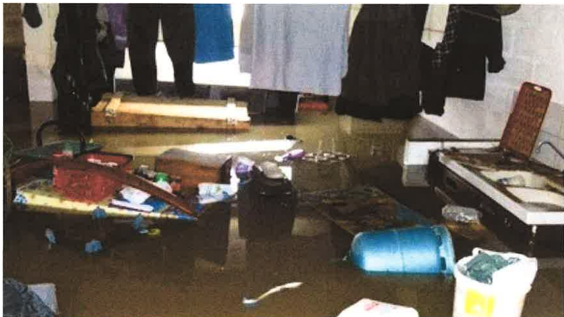
Le sous-sol d'une maison a été totalement inondé.
